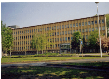
Bâtiment des Sciences
