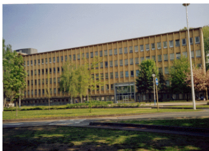
Bâtiment des Sciences
