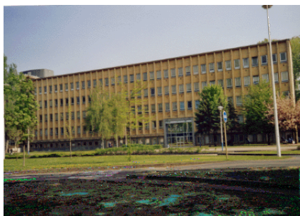
Bâtiment des Sciences
