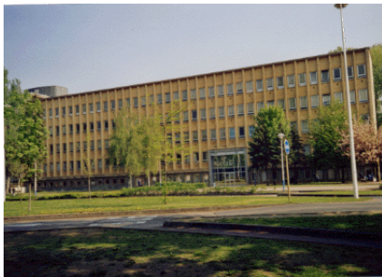
Bâtiment des Sciences
